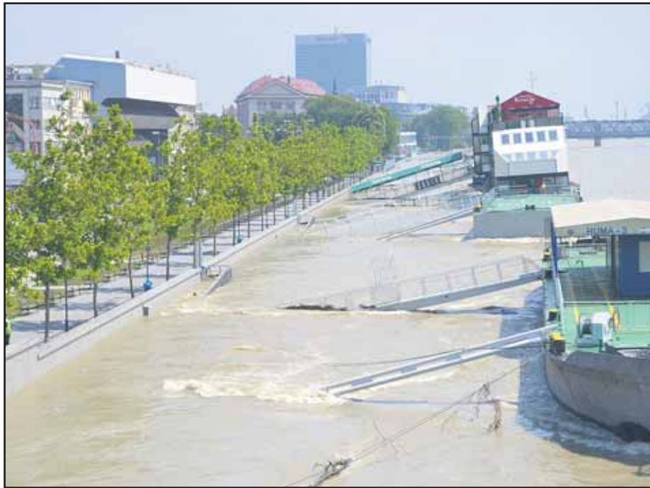
Bratislavu pred veľkou vodou tento raz ochránil protipovodňový múr.
