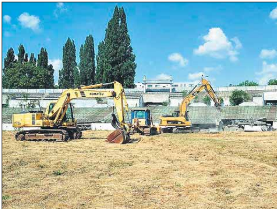
Výstavba nového štadióna sa začala búraním toho starého.
