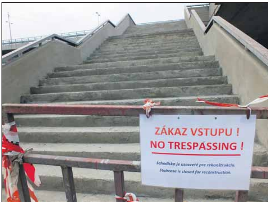
Schody na Most SNP sa nakoniec dočkali komplexnej rekonštrukcie.
