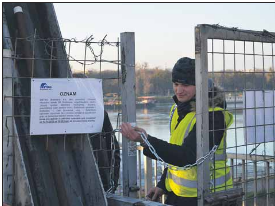
V pondelok ráno uzavreli Starý most pre verejnosť a začali ho rozoberať.
