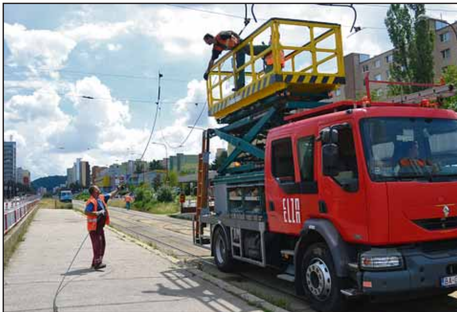
Rekonštrukcia električkovej trate sa začala zvesením trolejového vedenia.
