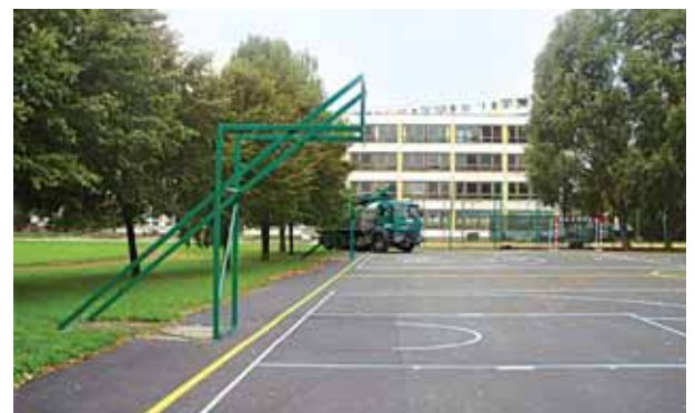
ZŠ Tupolevova. Na obnovených spevnených plochách sú už vyznačené čiary pre basketbal a hádzanú a čoskoro pribudnú opravené bránky a basketbalové koše.
