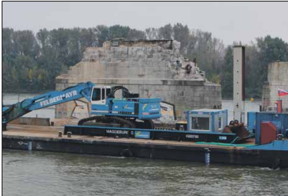
Rakúske bagre postupne rozoberajú prvý pilier Starého Mosta.
