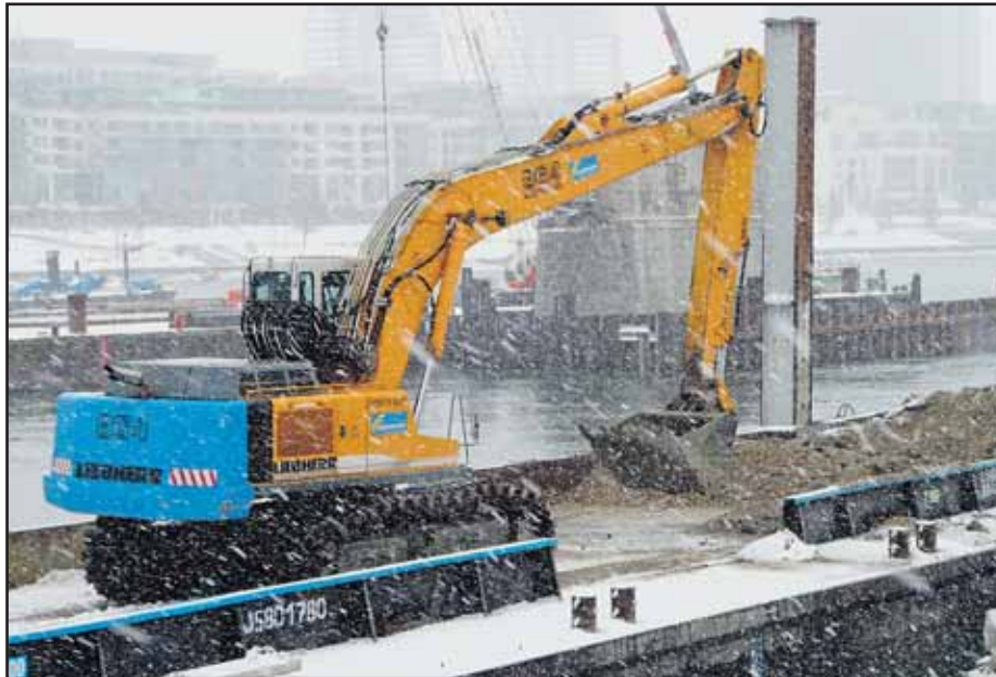
Práce na moste sa nezastavili ani počas pondelkovej chumelice.
