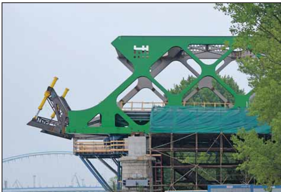
Konštrukciu mostu začínajú natierať zelenou farbou.
