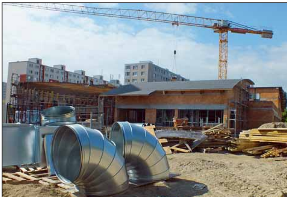
Budova plavárne ešte pripomína klasické stavenisko.
