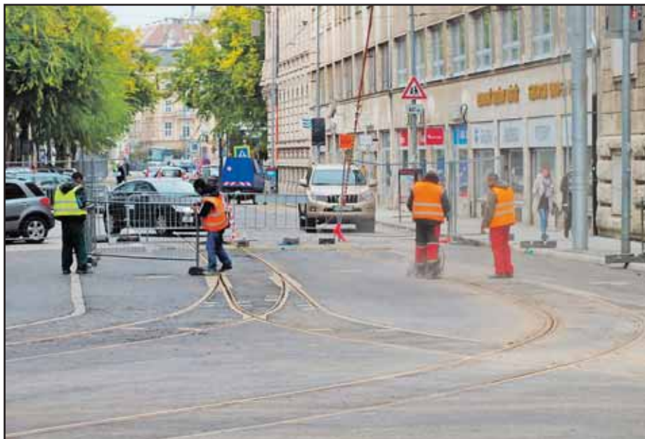
V pondelok sa na Jesenského ulici finišovalo s poslednými úpravami cesty. Foto: Juraj Mladý
